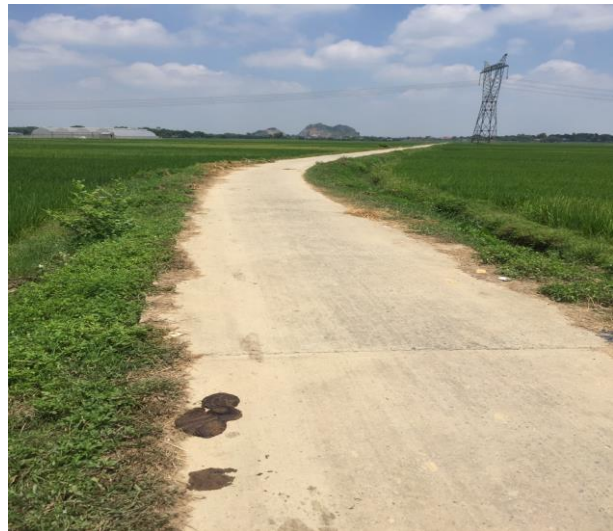
Hình 1.4. Hiện trạng tuyến đường liên thôn phía Nam dự án
