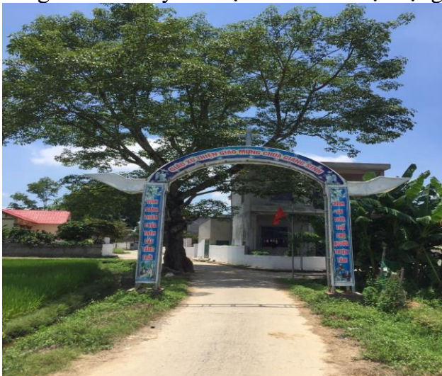
Hình 1.3. Hiện trạng tuyến đường liên thôn phía Bắc dự án
